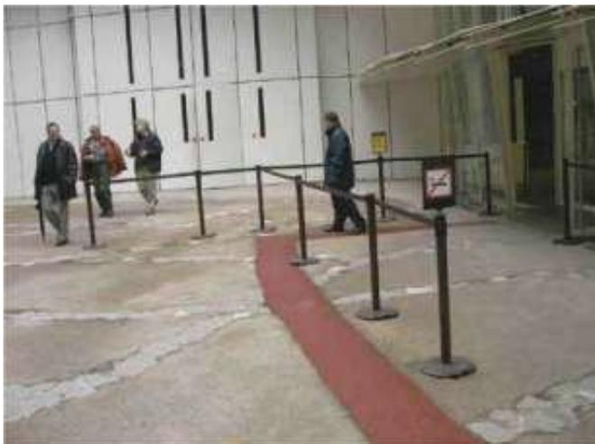
*Photo : Bande de guidage visible mais mauvaise mise en situation.*
