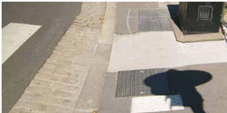
*Photo : Bande podotactile blanche interrompue suite à des travaux.*
