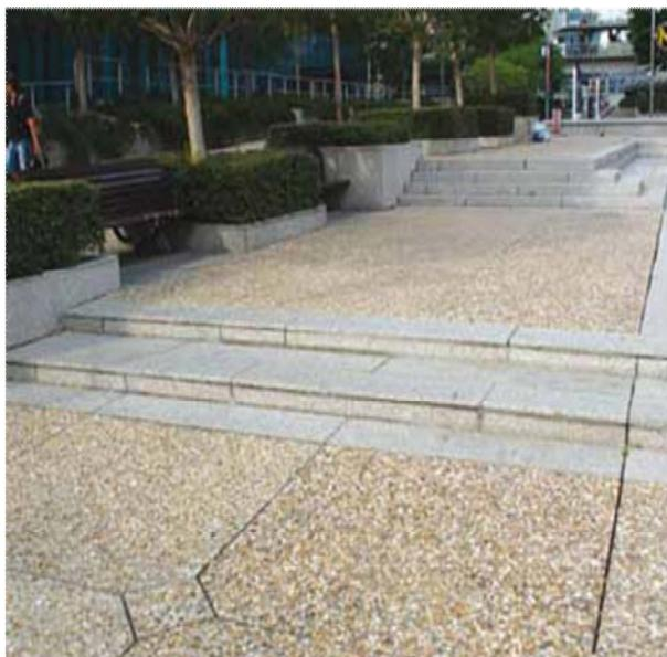
*Photo : Aucune main courante et dénivellations sans protection.*
